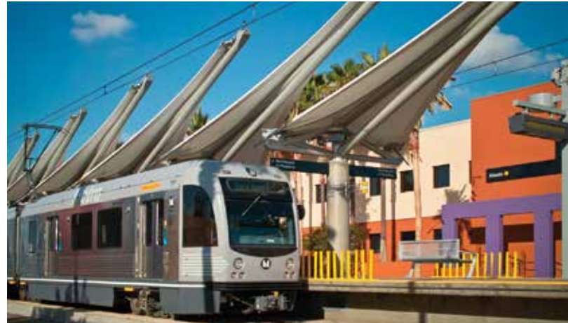
Estación Atlantic: Estación de Metro Gold Line en el este de Los Angeles.
