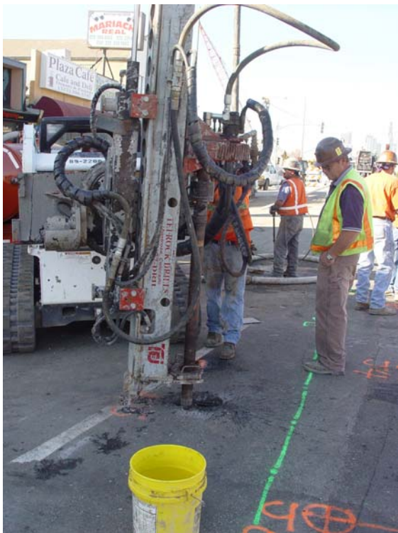
Taladrado y relleno de cemento en la 1a y Boyle
